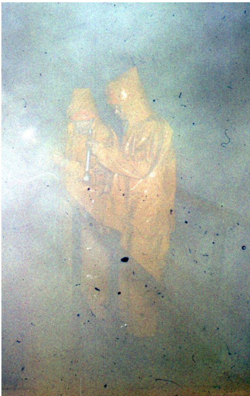
Zdjęcie wewnątrz chłodni kominowej; dwie osoby pracują z przyrządem pomiarowym wewnątrz chłodni.
